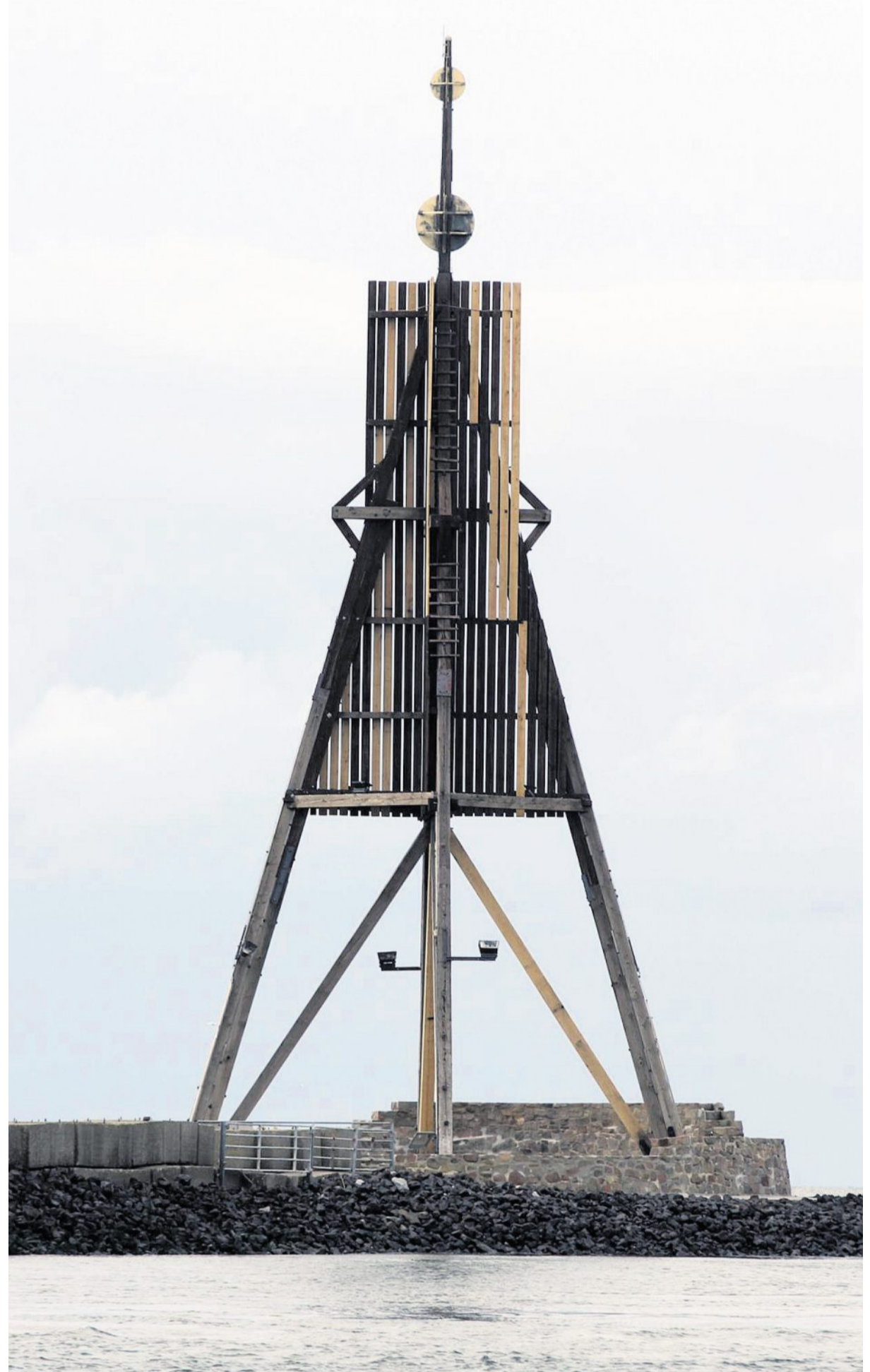
Alt und Neu sind gut zu unterscheiden: An der Farbe des Holzes lässt sich unschwer erkennen, an welchen Stellen im Zuge der jüngsten Renovierungsarbeiten Balken ausgetauscht wurden. Foto: Sassen
